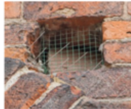
Fig.85: buca portaia: dispositivi anti piccione
