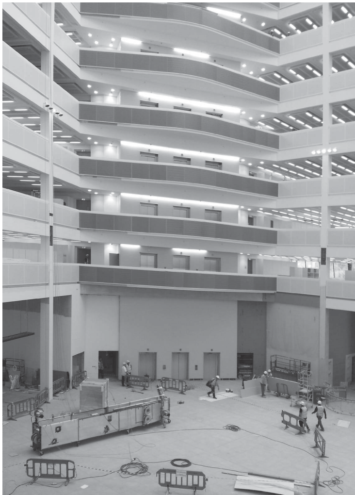
L'Angel Square a Manchester, in Inghilterra, è progettato per essere un edificio BREEAM Outstanding. (EG Focus)
