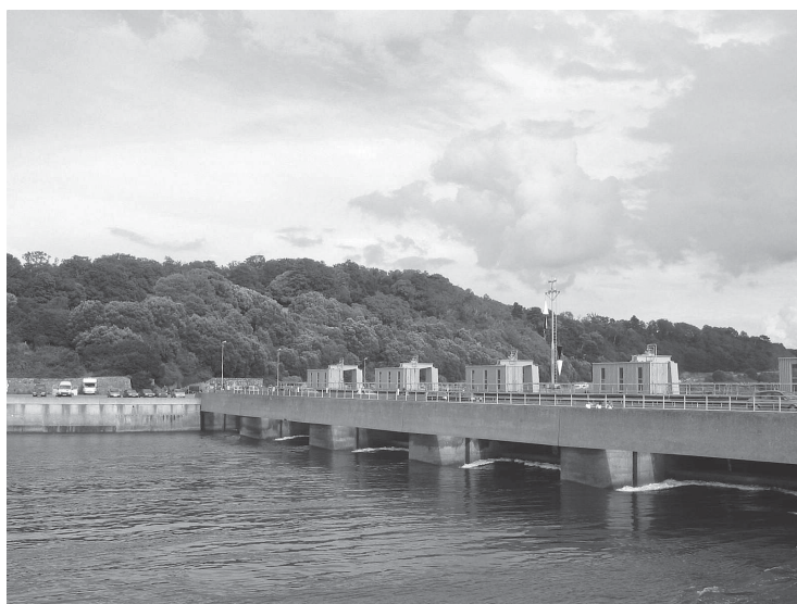
La diga della centrale di produzione elettrica dalle maree sull'estuario del fiume Rance, Bretagna, Francia. È attiva dal 1966. (Dani 7C3)
