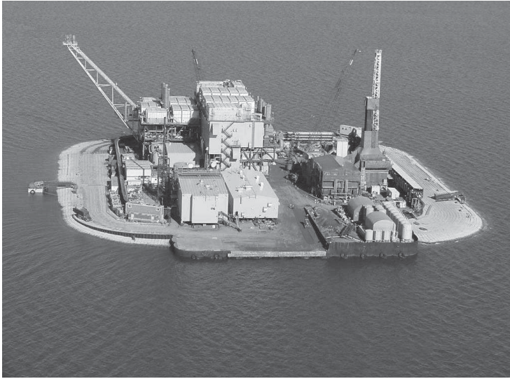
Un'installazione per l'estrazione di gas e petrolio su un'isola artificiale appositamente costruita nel Mare di Beaufort in Alaska. (Joint Pipeline Office)
